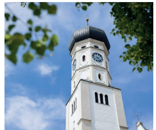
// Weithin sichtbar – der Kirchturm vom Ursberg.
